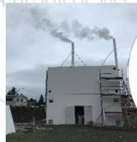
Pelletheizung (600 kW)
