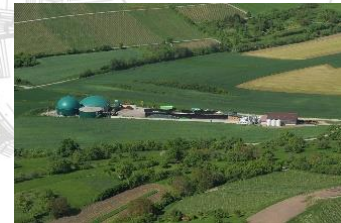
Biogas-Blockheizkraftwerk (rd. 800 kW) + Wärmespeicher
